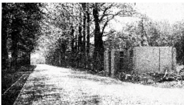
Tijdens de afbraak in 1936, gezien richting Langerak
