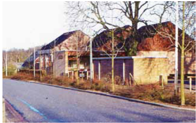
De nieuwe Van Schuylenburchschool die na enkele jaren alweer werd afgebroken (1977-1984)
