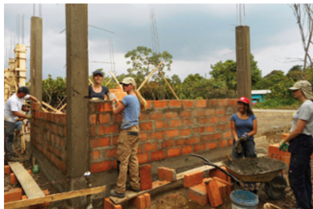
Begin bouwproject Ecuador, muur metselen
