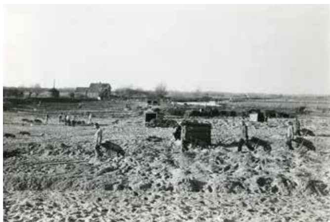
Graafwerk bij de kanalisatie van de Oude IJssel ter hoogte van het voormalige brugwachtershuis in Hoog-Keppel.
