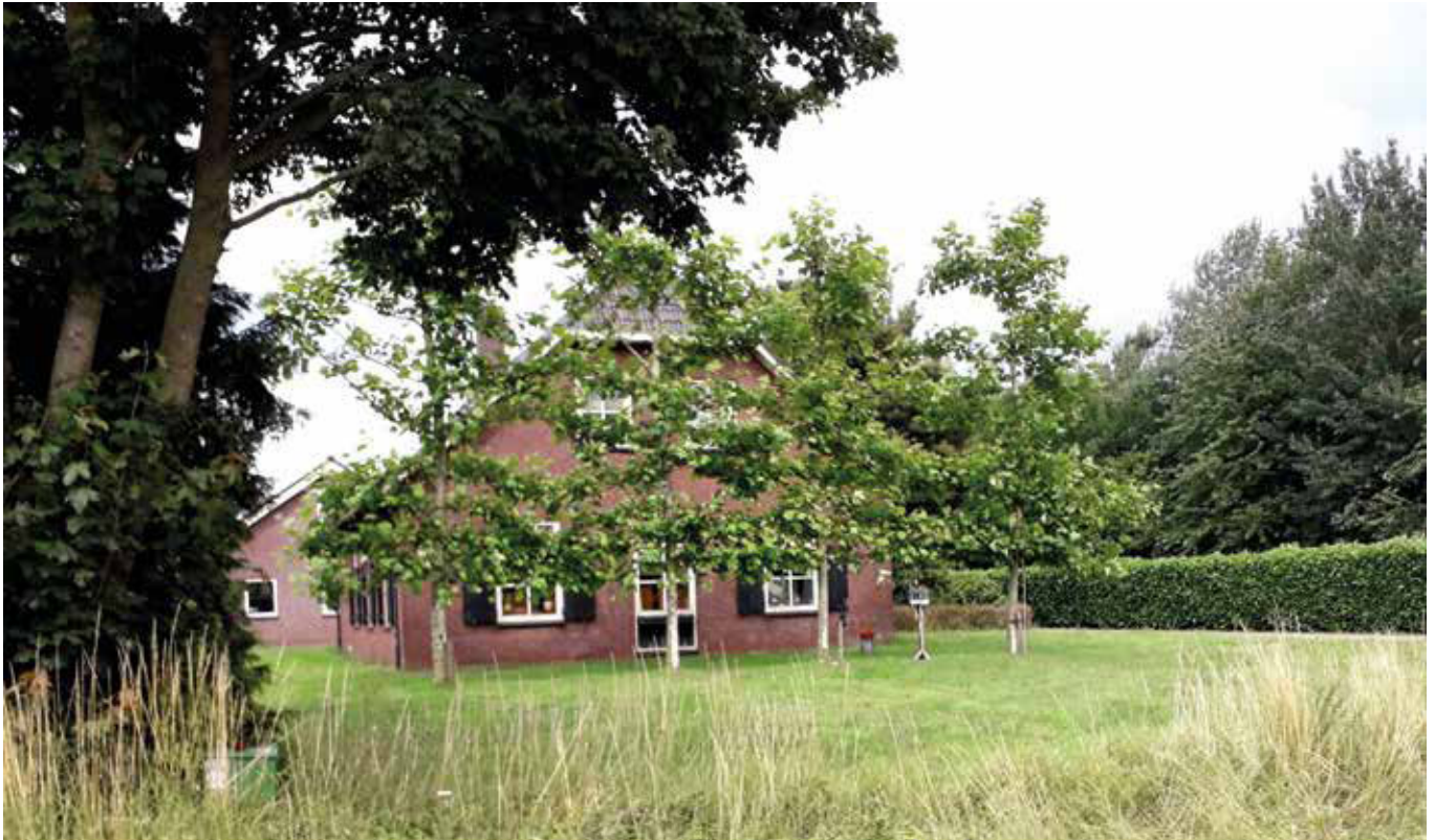
Eldrikseweg 4. Op de plek van het geboortehuis van Reinirus Lucassen is een qua vorm vergelijkbaar nieuw huis gebouwd.
