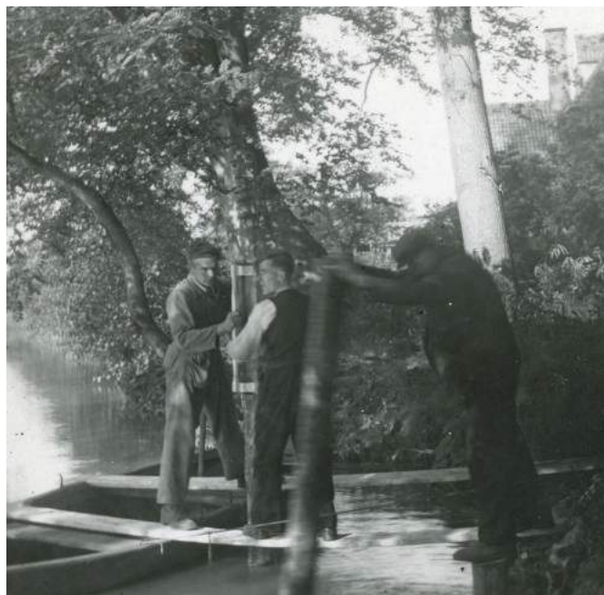
Voor de zomer van beginnen al de eerste voorbereidende werkzaamheden (1950).
