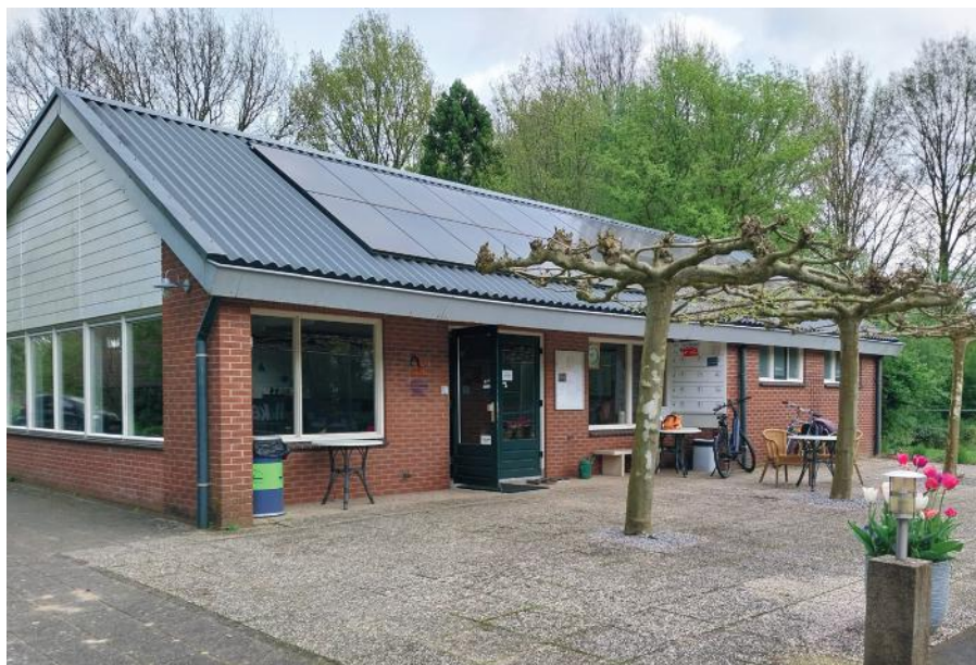
Het clubhuis met het nieuwe dak en de zonnepanelen.
