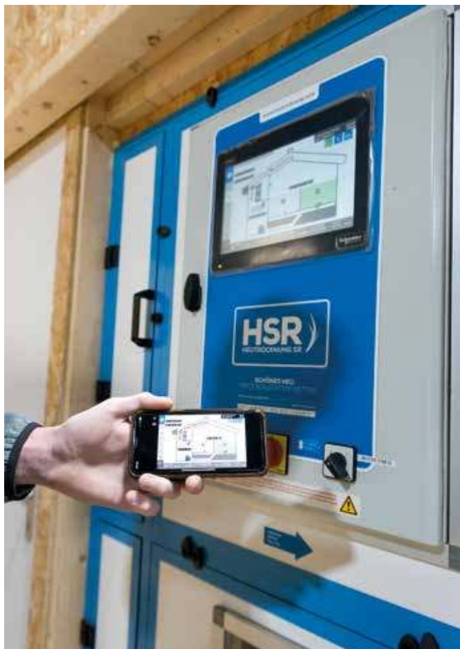
Het droogproces is computergestuurd en kan van begin tot eind gevolgd en aangestuurd worden via de smartphone.
