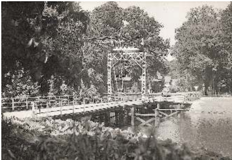
De brug over de Oude IJssel in de Dorpsstraat te Laag-Keppel.
