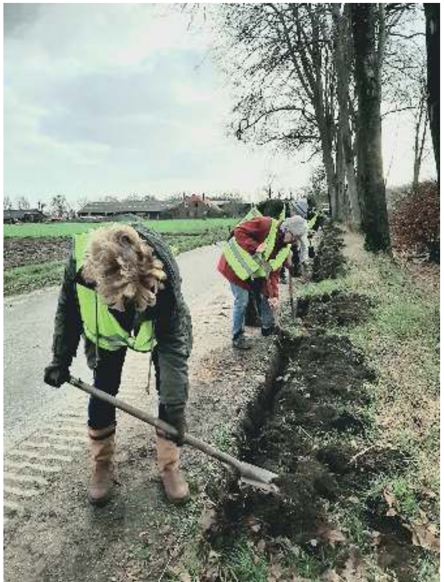
Het plaatsen van de schermen aan de Loenhorsterweg.
