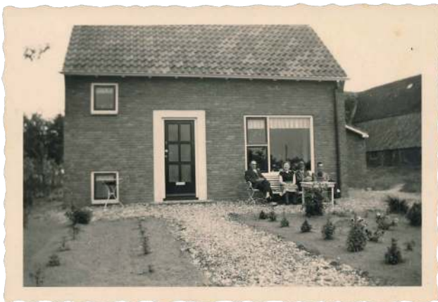
De nieuwe woning in 1956. Rechts van het huis is de oude boerderij nog te zien. In 1980 is daar een ligboxstal gebouwd.
