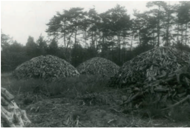
Meilers in aanbouw in de omgeving Wolfersveen (1935). Rechts: Het ontsnappen van de rook uit een met plaggen en zand afgedekte meiler, omgeving Ruurlo (1941).
