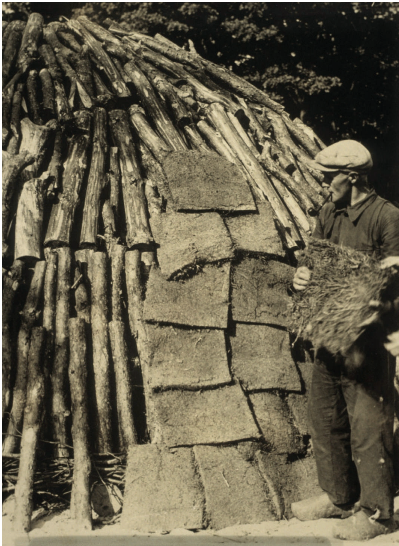
De opbouw van een meiler of koolhoop omstreeks 1930 in de omgeving van Hengevelde. De nauwkeurig geplaatste boomstammetjes worden met plaggen en daarna zand afgedekt.
