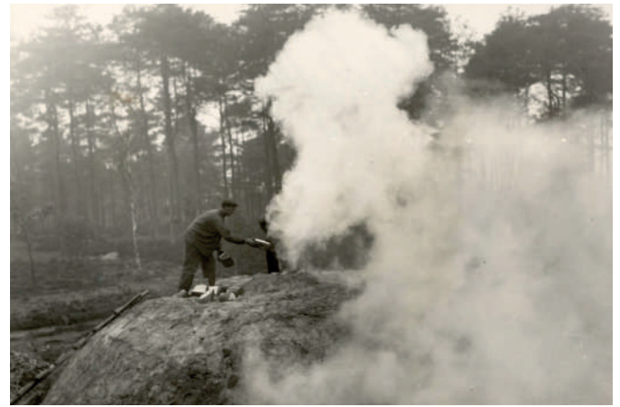
Meilers in aanbouw in de omgeving Wolfersveen (1935). Rechts: Het ontsnappen van de rook uit een met plaggen en zand afgedekte meiler, omgeving Ruurlo (1941).
